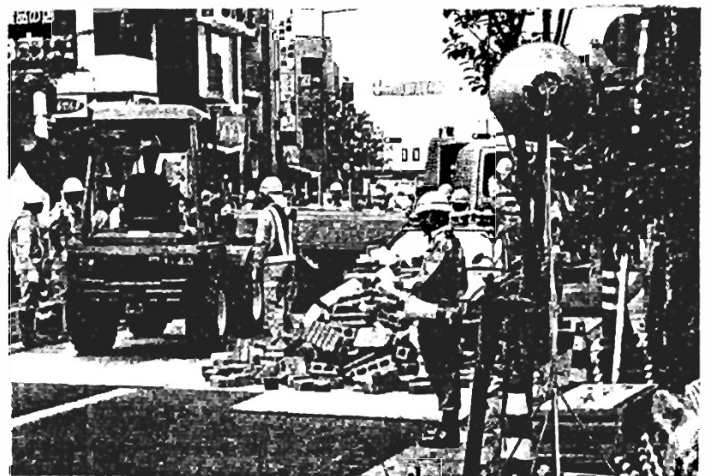
瓦礫に埋まっている乗用車の再現風景（道路啓開）
