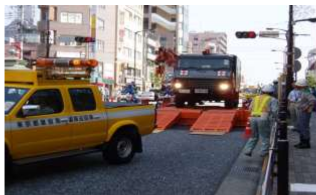
(仮橋を渡る緊急車両)
