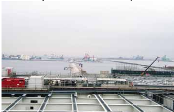
[栈橋部からの埋立部中締め切り]
