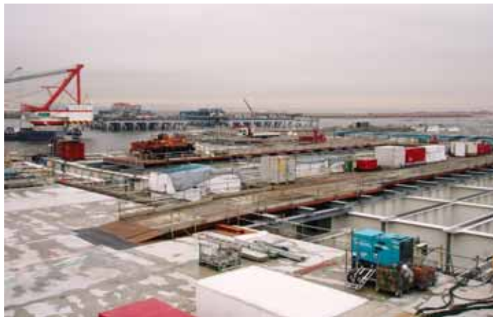
[施工中の栈橋部と連絡橋]
