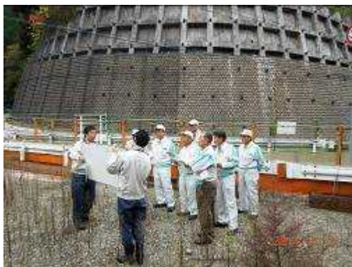
橋梁整備現場（本宿）で説明を受ける会員
