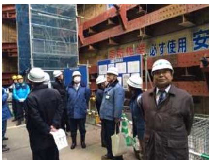
西武国分寺線 立体交差現場
