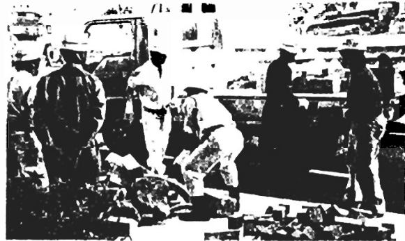
てきばきと(?)瓦礫を撤去する協会員
