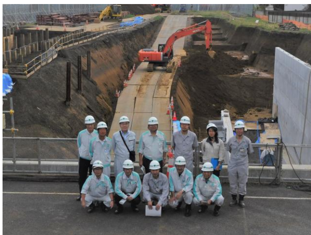
国分寺3・2・8擁壁設置工事現場
