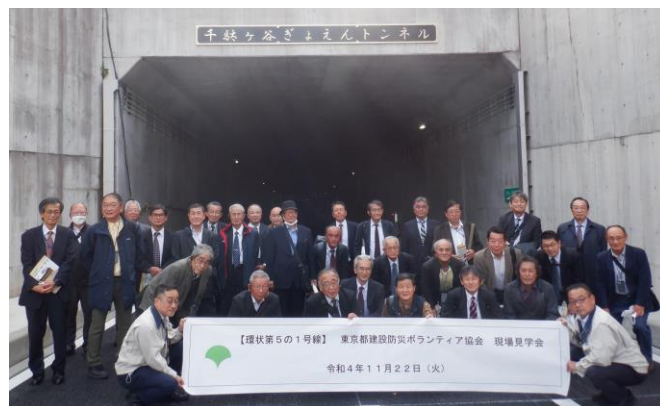
トンネル坑口新宿側にて
