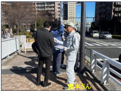
千住汐入大橋付近を点検中
