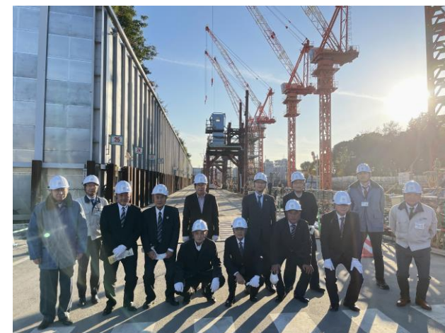
四建班現場見学会(城北公園調整池)も3年ぶり
