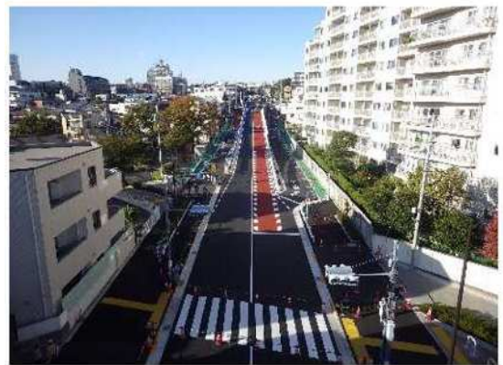
【②本線道路擁壁・副道部の遠景】
