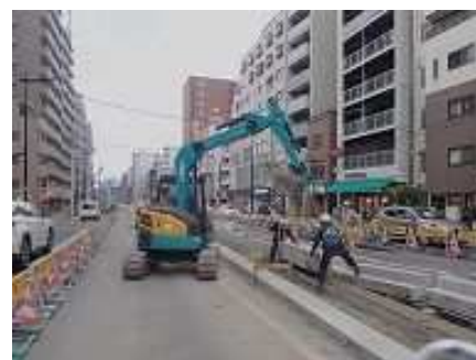
【中央分離帯設置工事状況】
