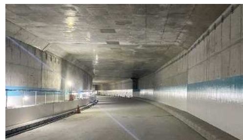
【築地虎ノ門トンネル未開通区間（施工状況）】
