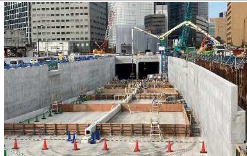
【旧築地市場地区の坑口部（施工状況）】
