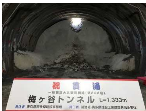
【梅ヶ谷トンネル】
