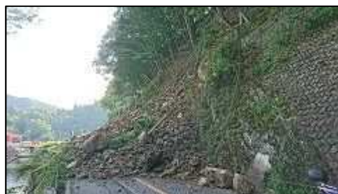
【斜面崩落の様子】
